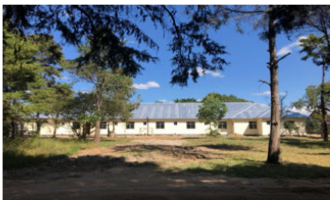
Vorbildliche Isolierstation des Hospitals in Sumbawanga in Tanzania
