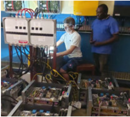
Thomas Jäger bei der Reparatur der Solaranlage in Kaseye
