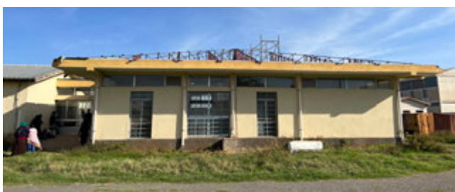
Renovierung des Daches im OP
