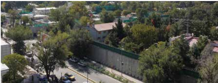
Kabul 2022 Hochsicherheitsstrakt 6m hohen Betonmauern zwischen den Stadtteilen
