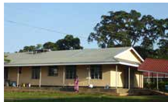
frisch renovierte Station
