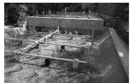
Bau der biologischen Kläranlage 2
