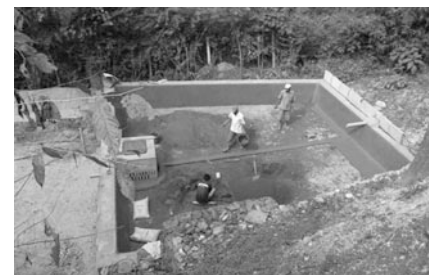
Bau der biologischen Kläranlage 1
